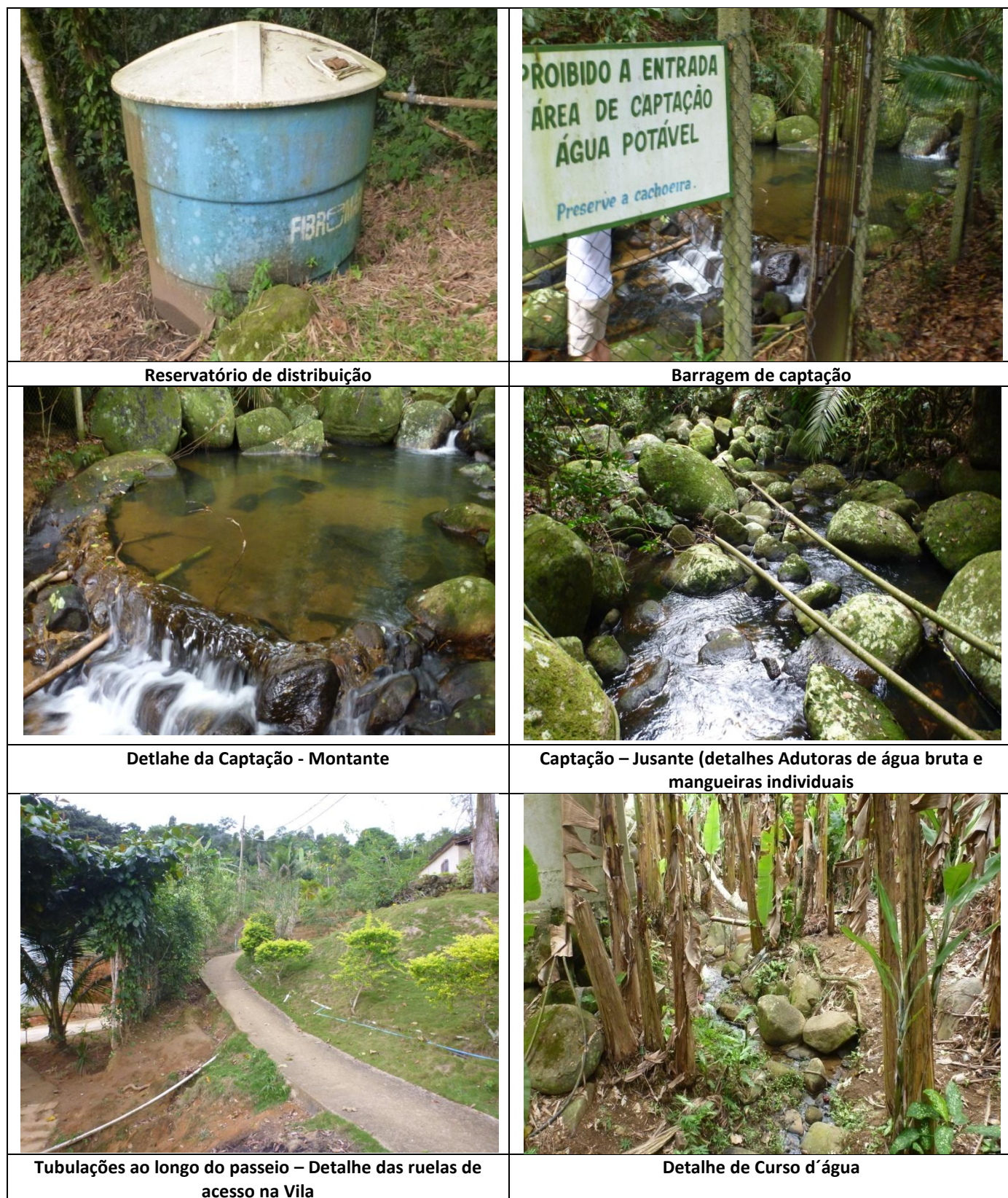
Figura 5.1.1-VII: Memória Fotográfica - Sistema de Abastecimento de Água Praia do Longa
