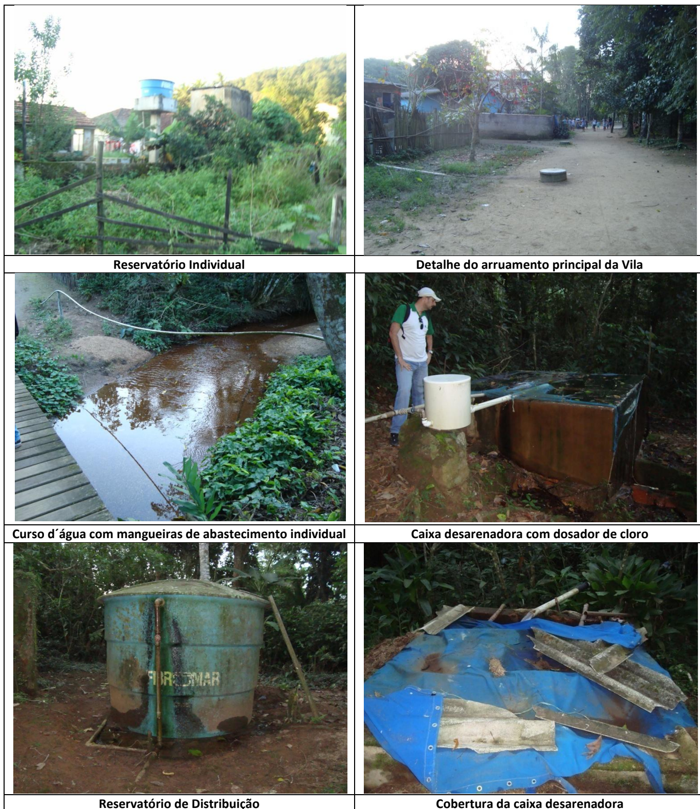
Figura 5.1.1-X (1/2): Memória Fotográfica - Sistema de Abastecimento de Água da Vila Matariz
