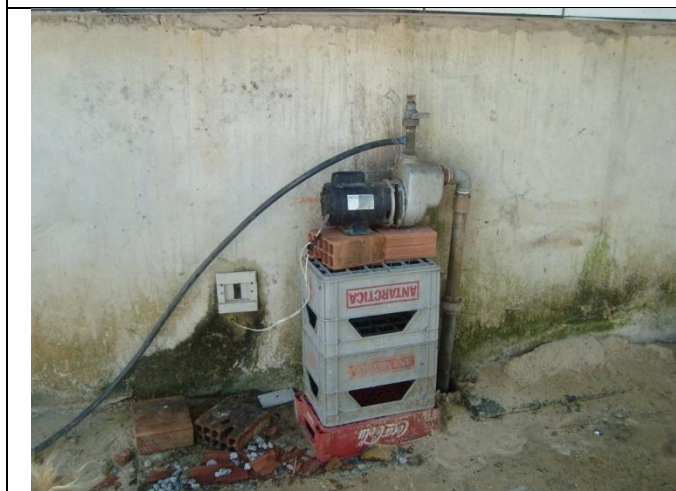
Sistema de Bombeamento de efluentes dos sumidouros existentes para zona de bambuzal na mata – lado direito da praia – Restaurante Mandala
