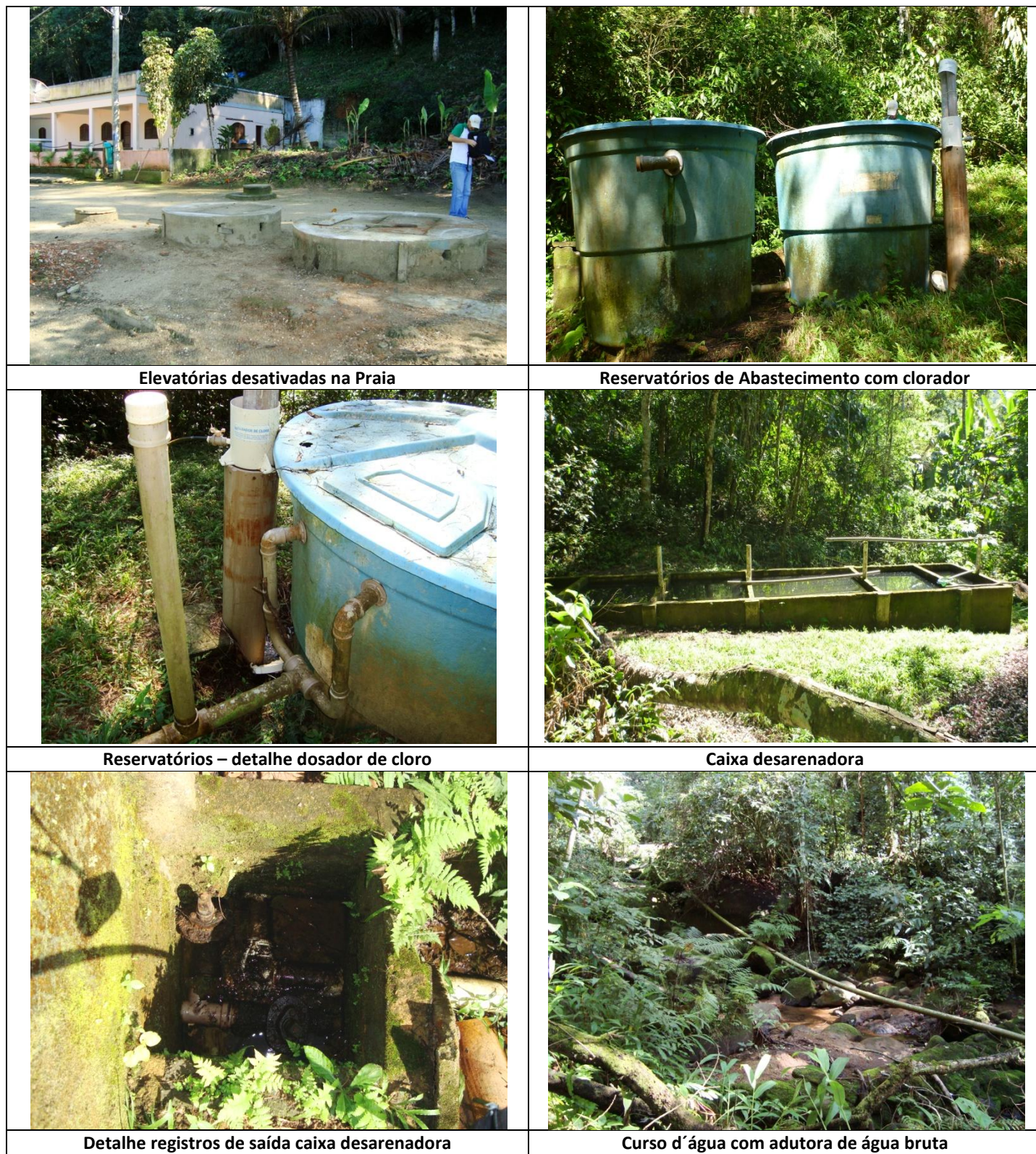
Figura 5.1.1-IX (1/2): Memória Fotográfica - Sistema de Abastecimento de Água da Vila do Saco do Céu
