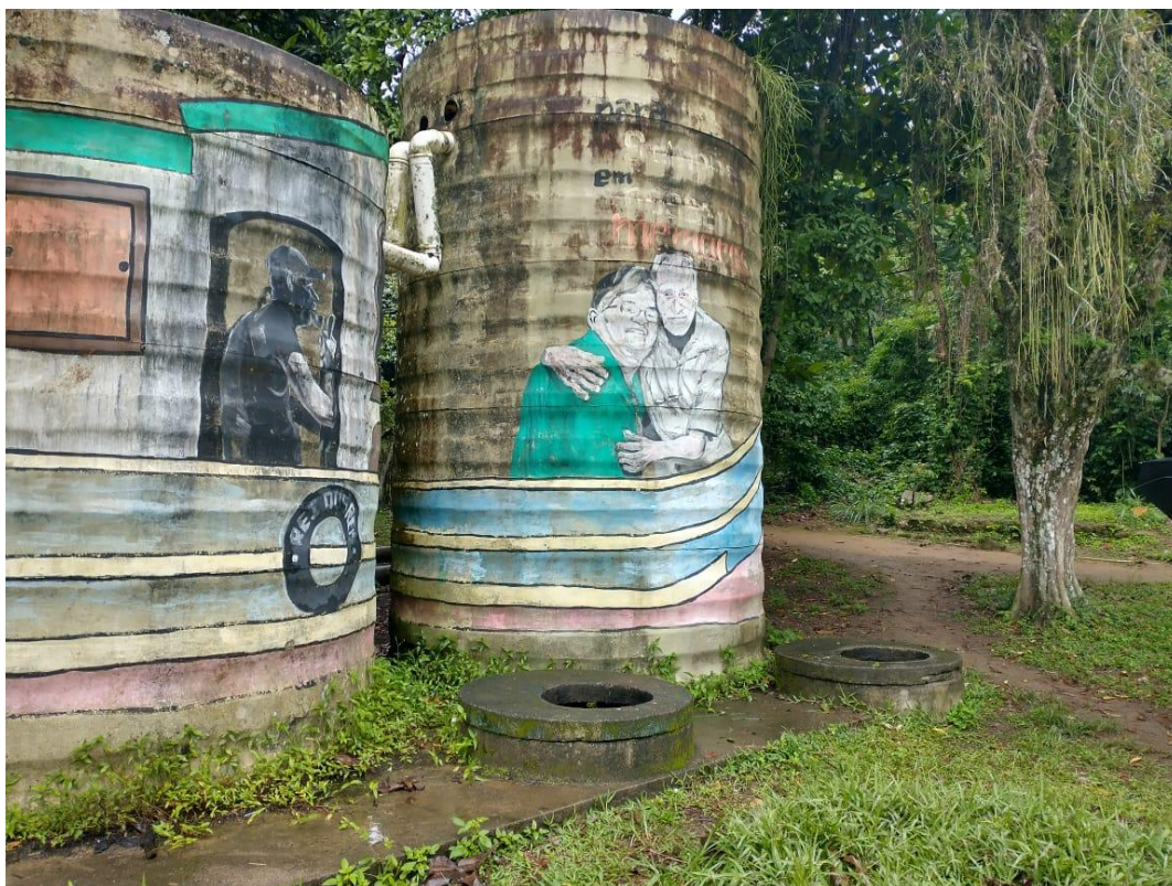
Figura 12 - Projeto de tratamento de esgoto abandonado pela prefeitura. Foto da autora, 2021.
