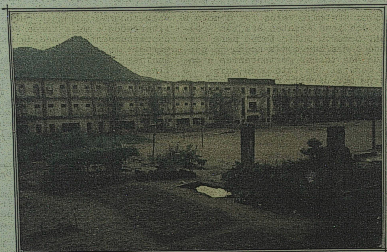
A Penitenciária Cândido Mendes, vista pela parte dos fundos nos últimos momentos que precedia a implosão em 1994
