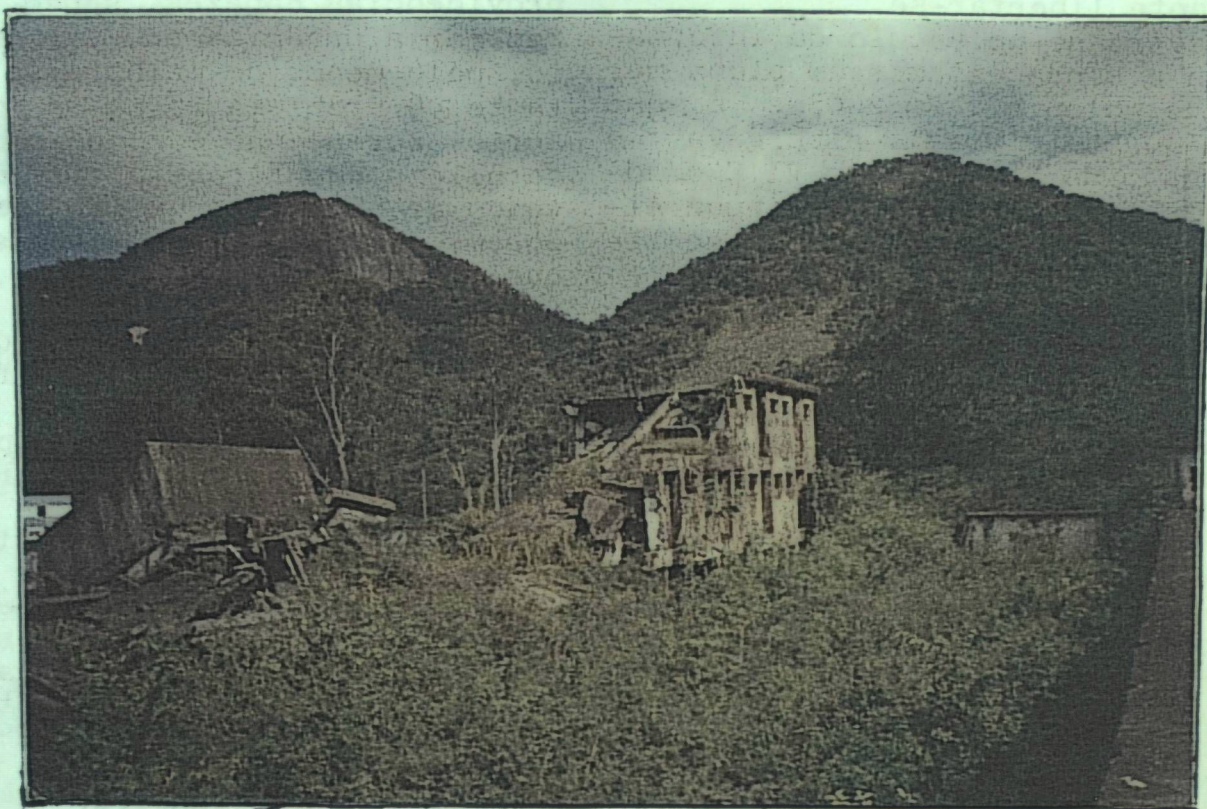
A CAIXA D'ÁGUA e uma parte do ANEXO, resistiram a implosão, abril de 1994
