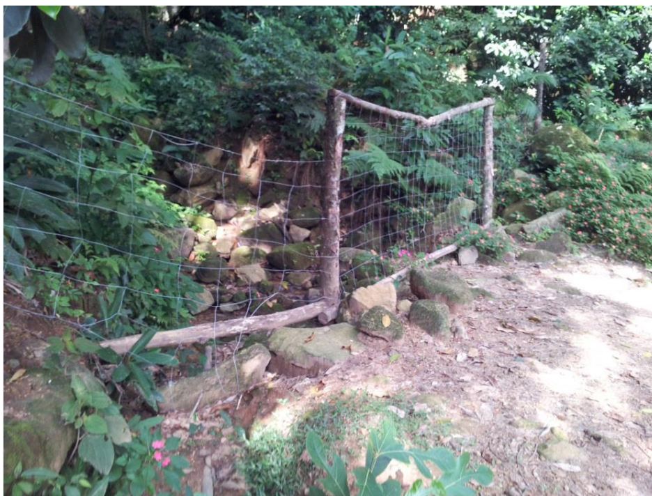
Figura 16 – Manejo de trilha após deslize de pedras na estrada Dois Rios.
