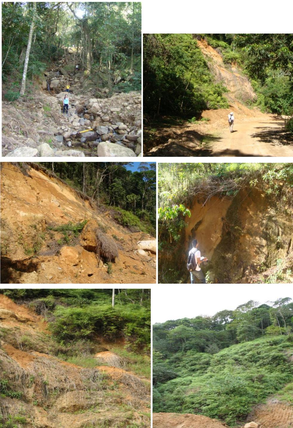
Figura 36 - Áreas frágeis com deslizamentos periódicos na estrada da Colônia
