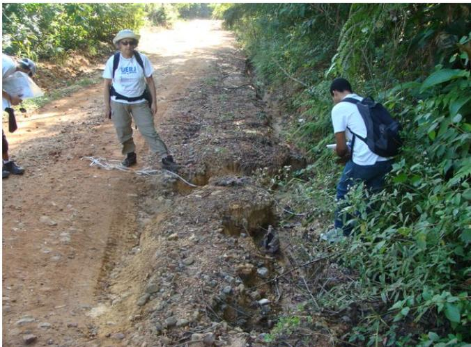
Figura 34 - Canaletas sofrendo erosão ao longo da estrada da Colônia
