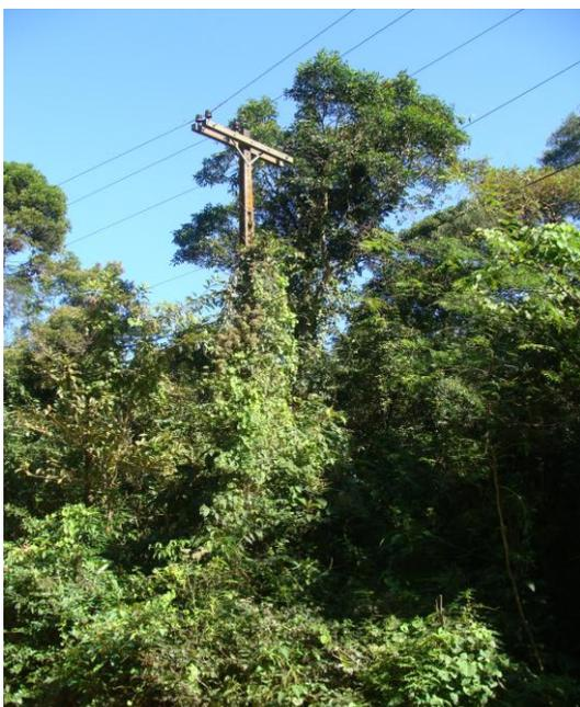
Figura 33 - Fiação elétrica próxima às copas das árvores na estrada da Colônia
