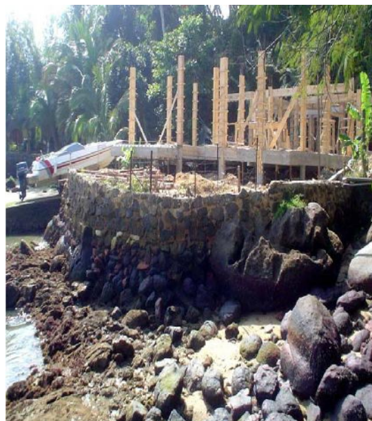
Figura 29 - Construção no costão
