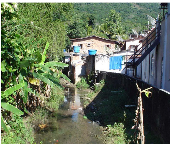
Figura 26 - Construções à margem do rio da Assembléia Fonte: Acervo NEPPT (2005)
