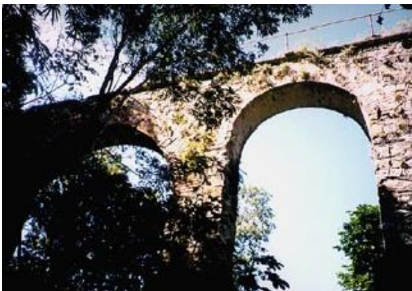
Figura 13 - Resquícios do Aqueduto localizado em Abraão Fonte: Biblioteca Municipal de Angra dos Reis
